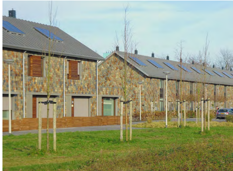
Eenvoudige dakvorm met nokrichting evenwijdig aan de straat
