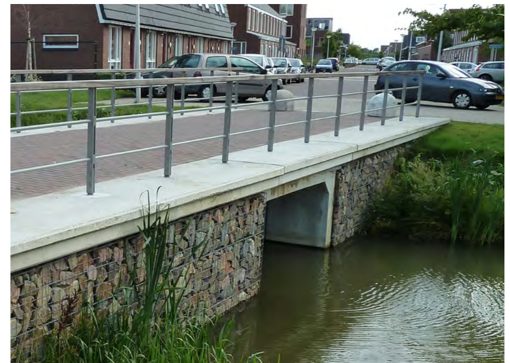
Voor auto's kunnen ook duikerdammen toegepast worden
