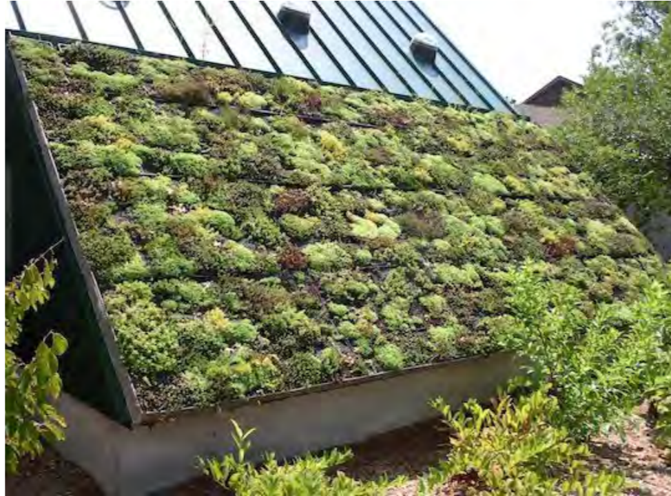
Sedemdak op hellende vlak
