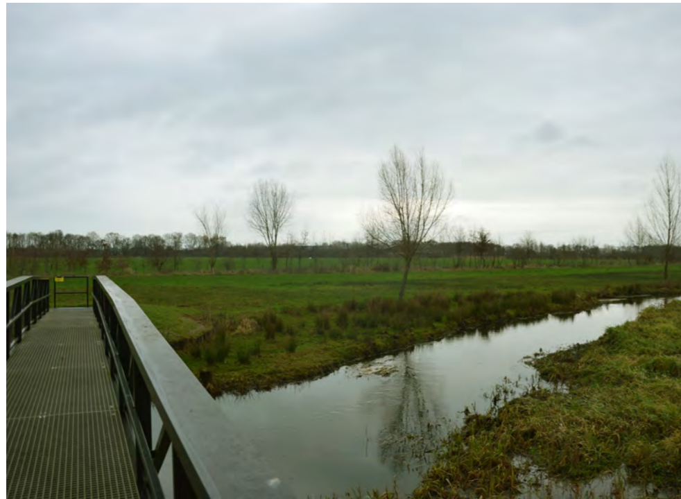
Bestaande brug over de beek tegenover de Watertuin eventueel verplaatsen
