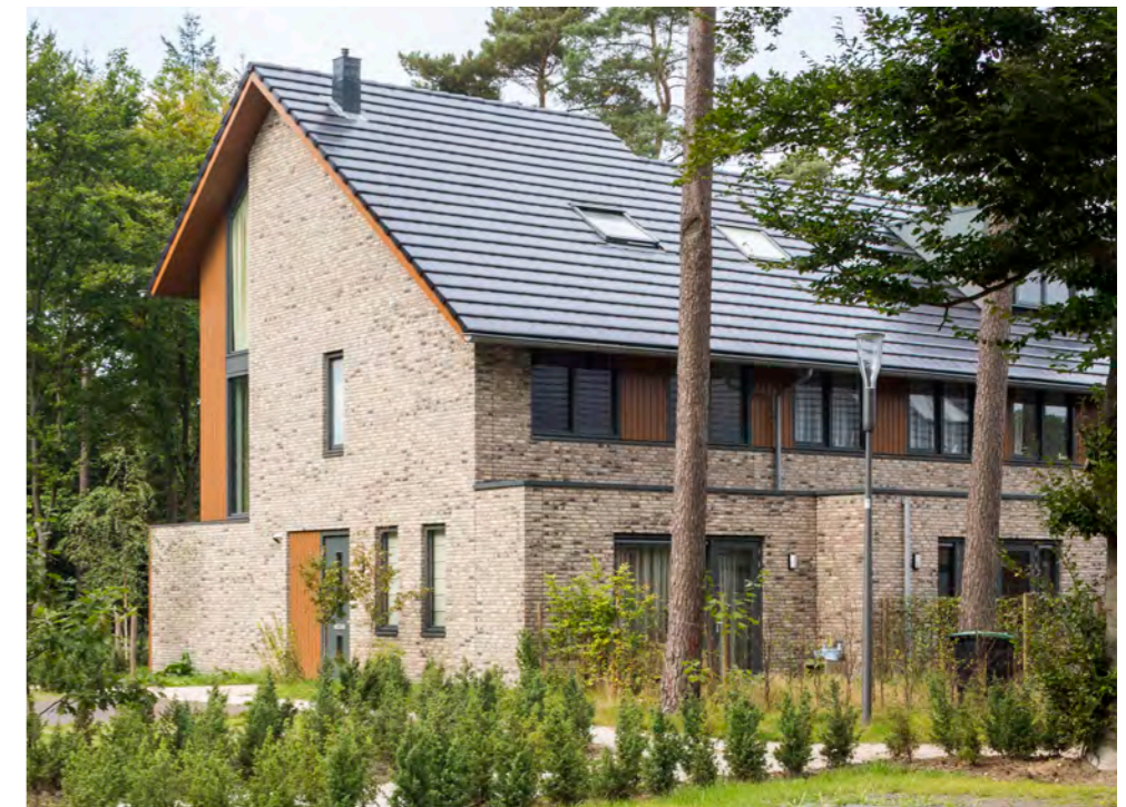
Kopgevel gericht op het groen
