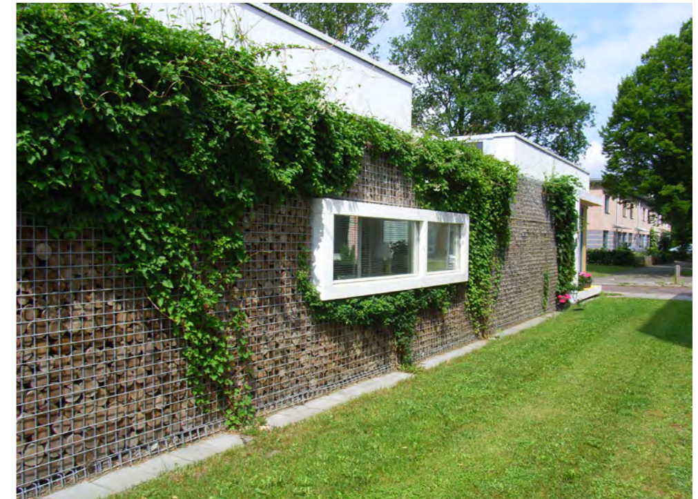
Tuinmuur in woningontwerp opgenomen
