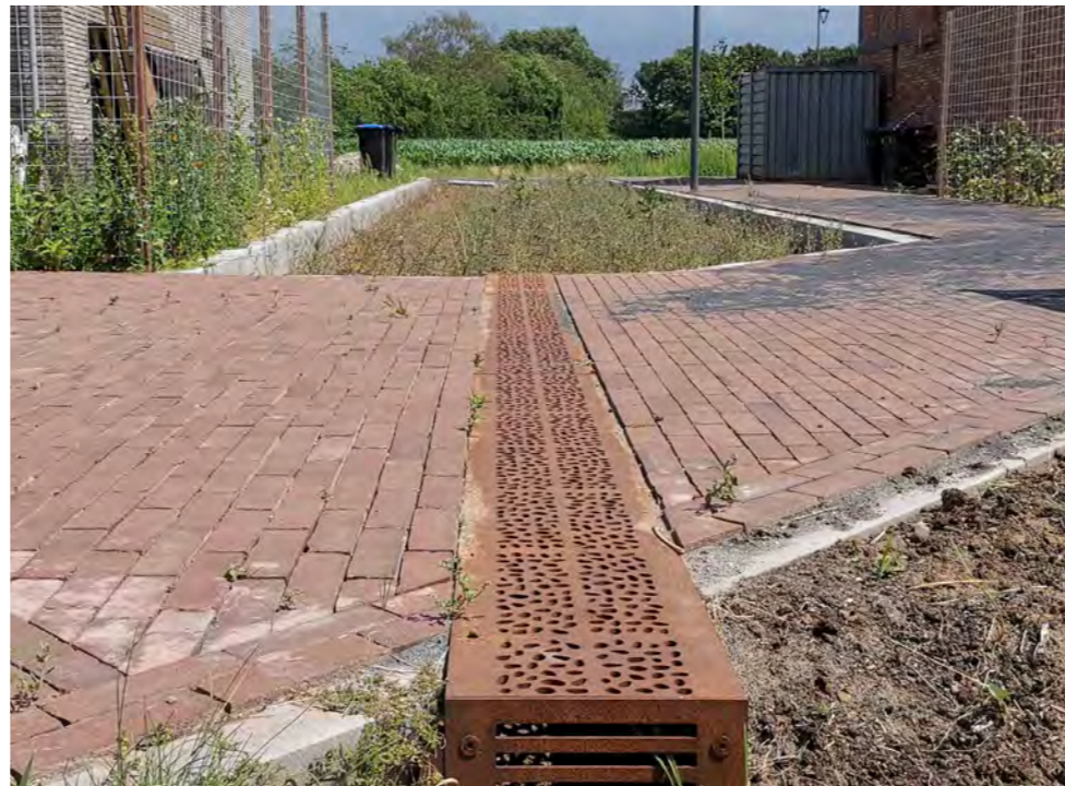
Smalle strook in de rijbaan uitgevoerd van ander materiaal over de wadizone
