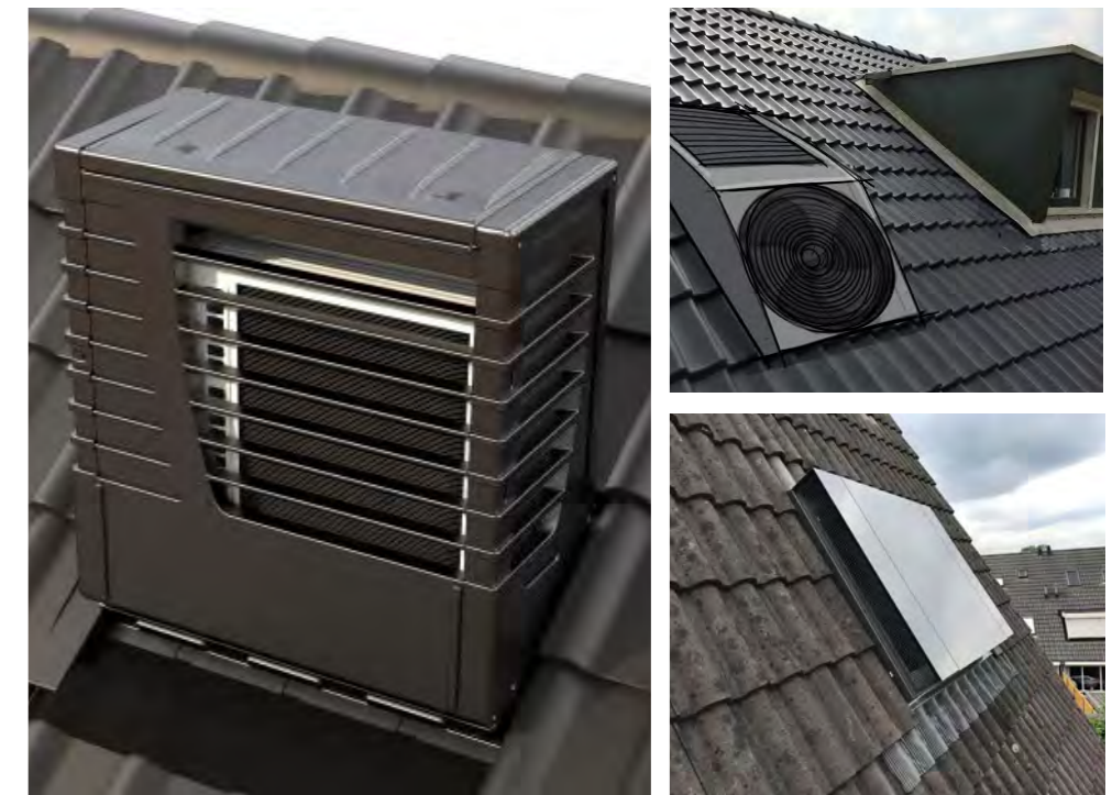
Buitenunits geïntegreerd in het bouwvolume
