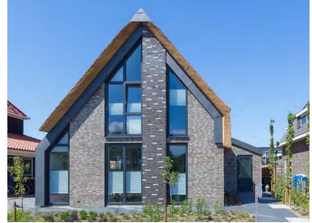
Gevels onder de kap worden in stroken opengewerkt en zijn het gezicht van het ontwerp
