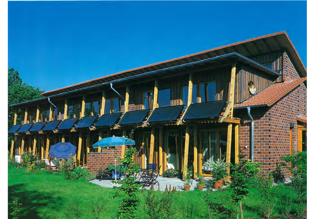
In dit voorbeeld zijn zonnepanelen niet in het dak opgenomen maar zijn onderdeel van de architectonische vormgeving
