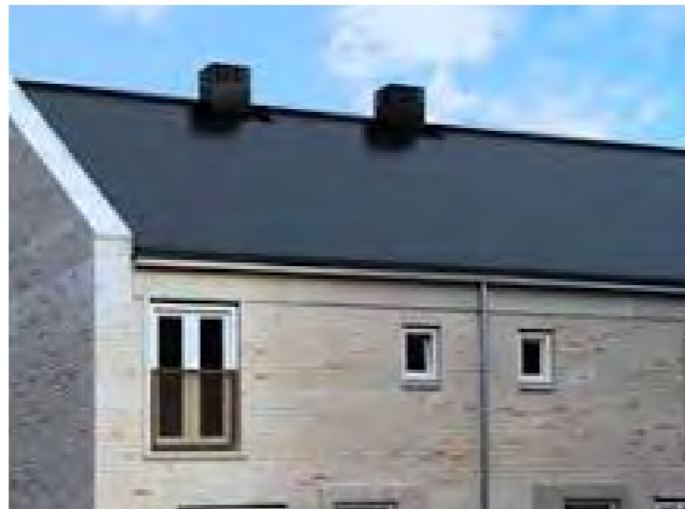
Buitenunits van warmtepompen geïntegreerd als schoorsteen
