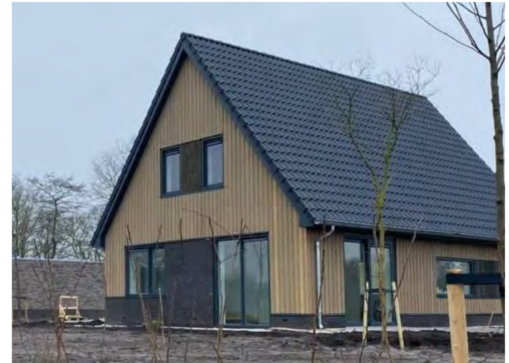
Antraciete dakpannen en natuurlijk materiaal voor de gevels
