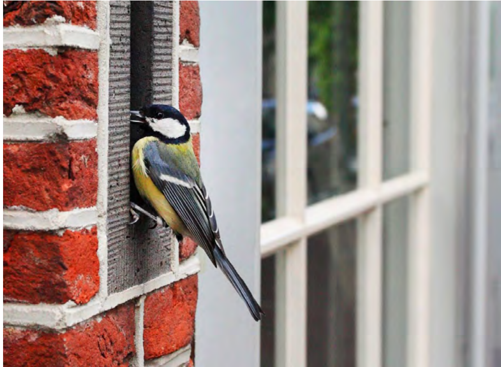
Gevelstenen waarin nestmogelijkheden zijn
