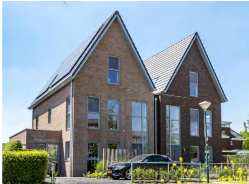
Nokrichting dwars op de straat, twee woningen met ieder een eigen kap
