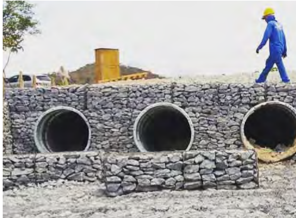
Grote duikers zijn naast elkaar aangelegd om een brug te omvormen
