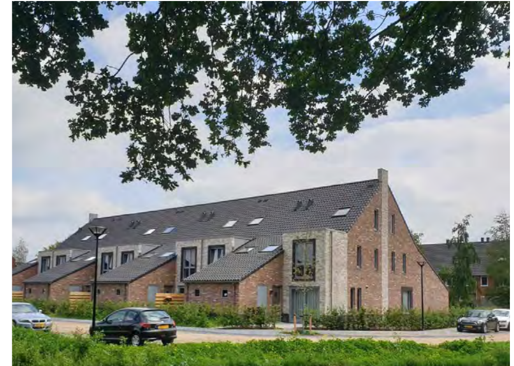
Doorlopende dakvlak bij de rug-aan-rug woningen in Beekweide I (in Beekweide II zijn de rug-aan-rug woningen één laag hoog met een (woon-) daklaag)
